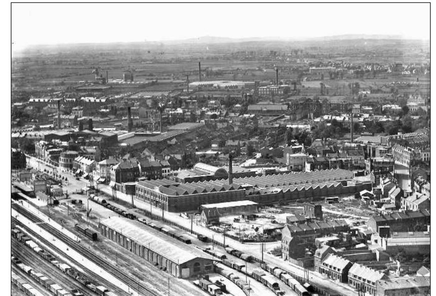
Les archives témoignent de la transformation de la ville : A.M.A .3 Fi 616 Le quartier de la gare reconstruit en 1926.
